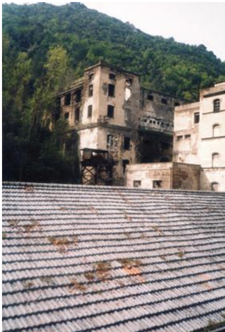
6) Il tetto della dismessa centrale di Papigno, grigio per il deposito di calciocianammide (archivio Papuli).
