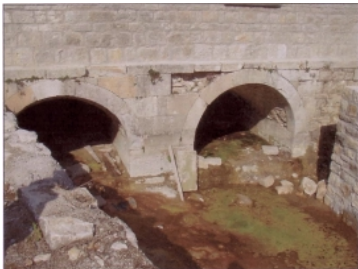
Roseto Valfortore (FG). Mulino idraulico, particolare della doppia bocca di scarico.
